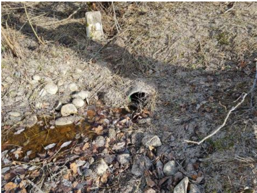
Kuva 4. Liittymiskohta Kuukantien hulevesiviemäriin. Kuva: Janne Koskenkorva.
