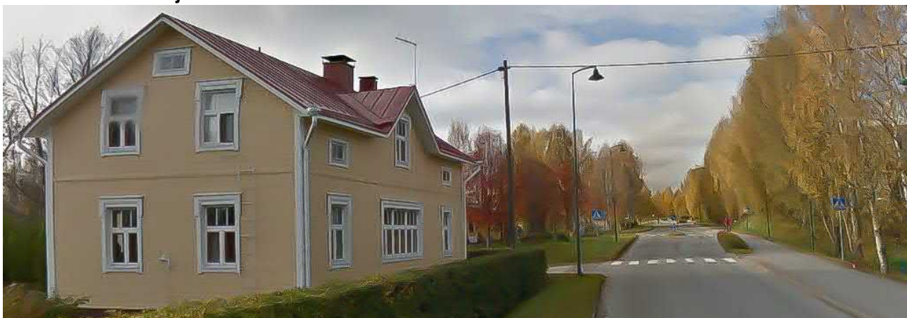
Kuva 16: Kuukantien raittimiljö (Kuva: ©Google)
