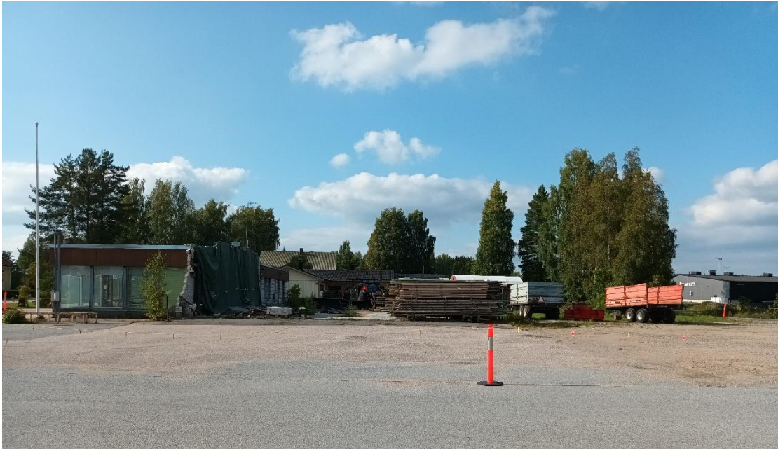
Kuva 14. Vanhan huoltoaseman takapuolella ollut huolto- ja korjaamosiipi tuhoutui tulipalossa v. 2016.
